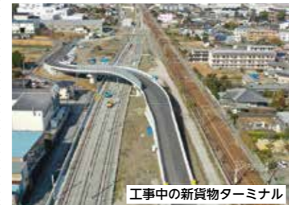
工事中の新貨物ターミナル
